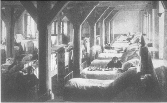
Fig. 6. Interior of Salpêtrière wards ( salle Lavoisier , bâtiment Parmentier/Saint Léon). In Guillaín and Mathieu 22. Photograph © AP HP/Photothèque.
